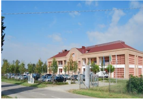
Edificio principale e laboratori
